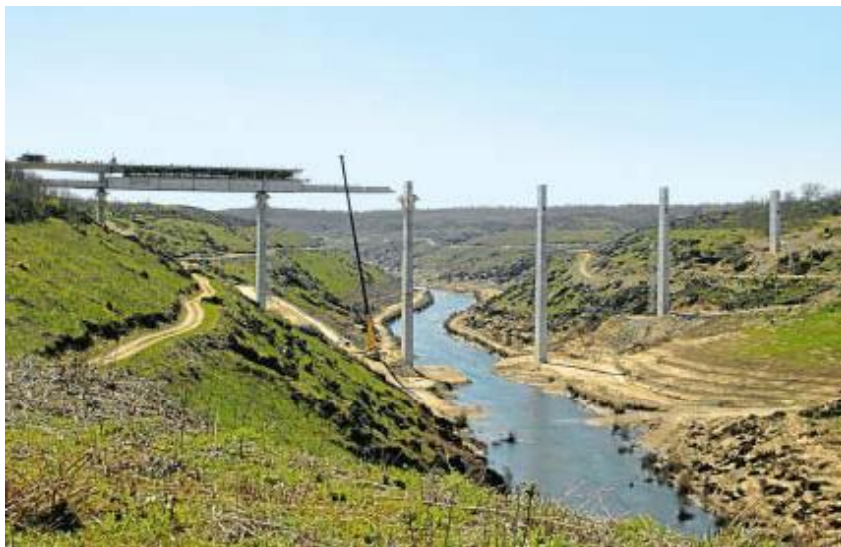
Estado actual de las obras de la variante de Robleda sobre el embalse de Iruña. /FOTOS: CASAMAR
